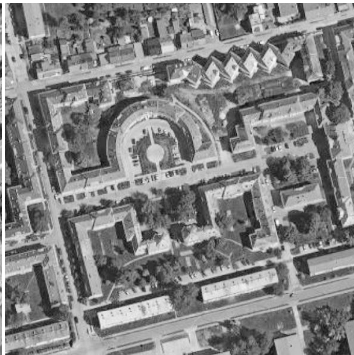
zástavba heterogenní úřednické domy Vítkovických železáren Ostrava-Hrabůvka
