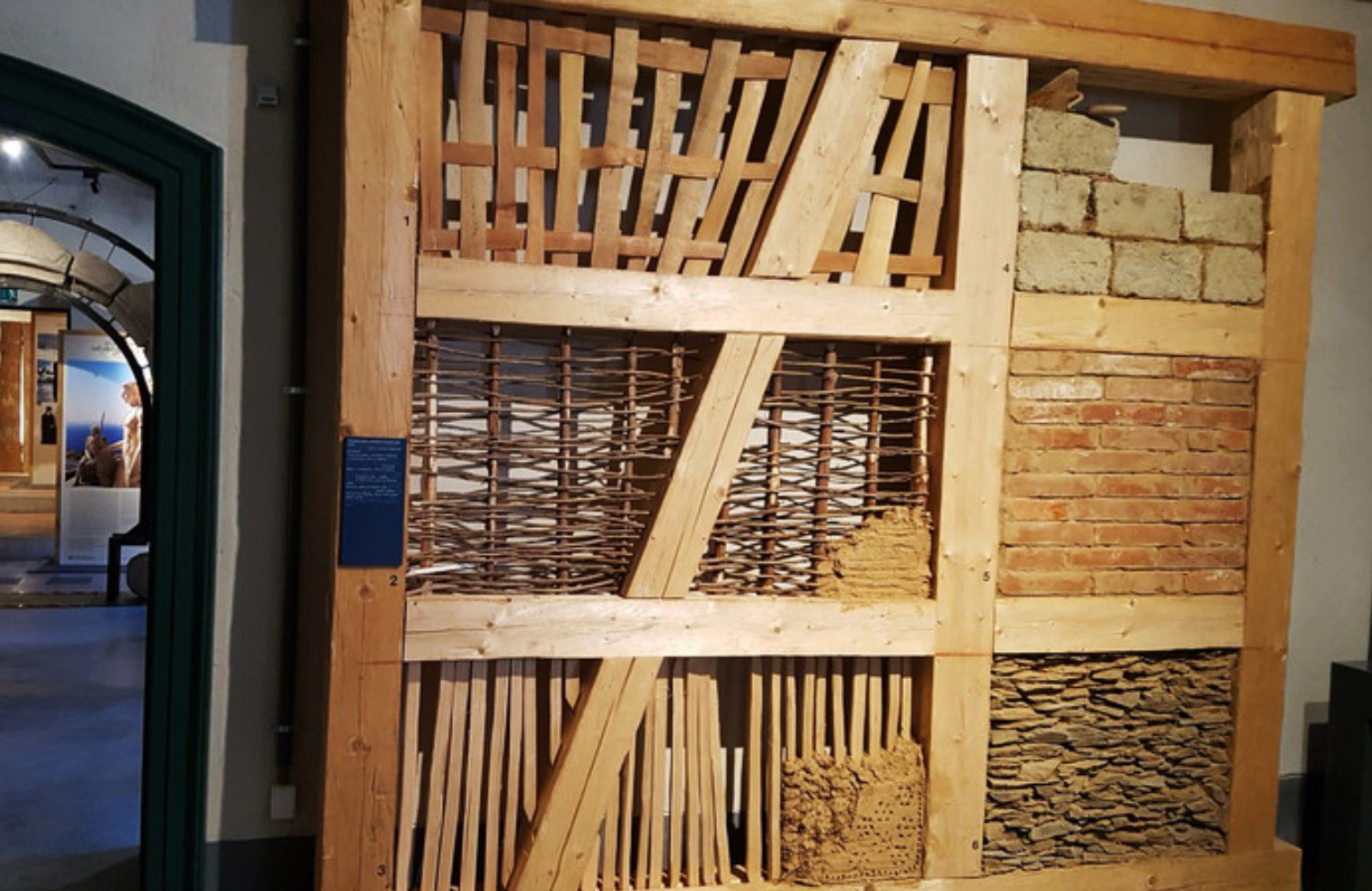
Plasy (ČR, okr. Plzeň-sever), Centrum stavitelského dědictví NTM, maketa rámovej konštrukcie s ukázkami rozličných typov výplní (foto. M. Babická, 2018).
