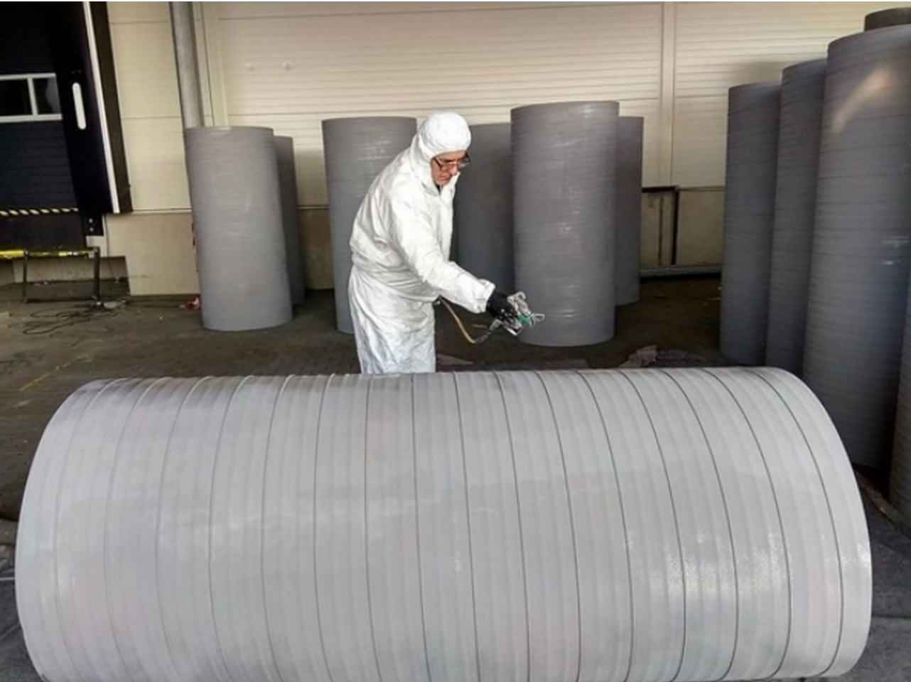
Nástřik izolace na vzduchotechnické potrubí, Zdroj: fotoarchiv Aditex, spol. s.r.o.
