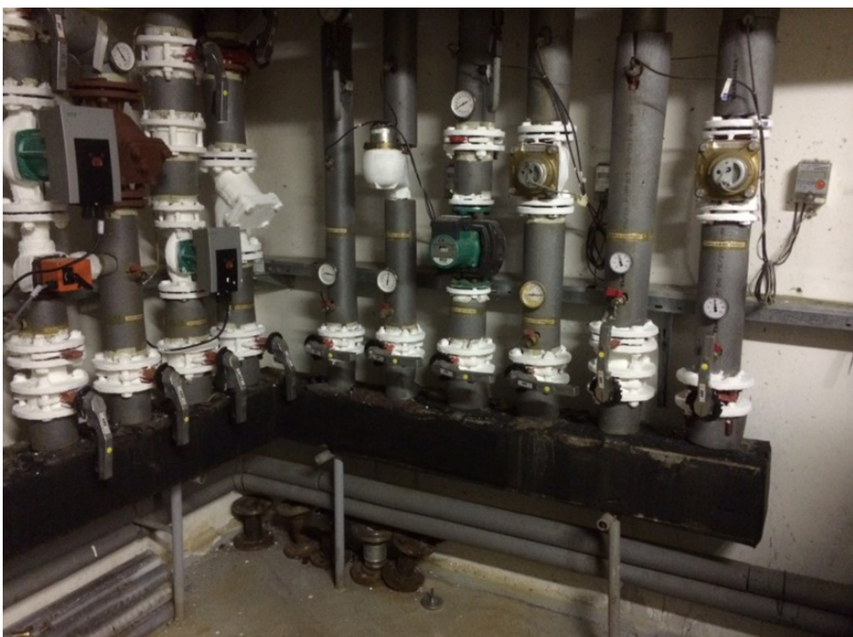
Zaizolování armatur kotelný v bytovém domě, Zdroj: fotoarchiv Aditex, spol. s.r.o.
