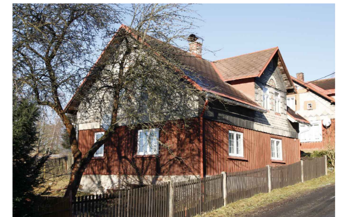
Obr. 5: Dům č. p. 505 v roce 2016, Bublava. Přízemí dvoupatrového rodinného domu je obloženo ještě původním svislým přísným bedněním s krycími listy. Patro má ornamentně vykládané eternitové šablony v duchu německého Heimatstilu. VÝŠKOVÁ, Dominika (fotograf), 2016. Vlastní archiv autora.
