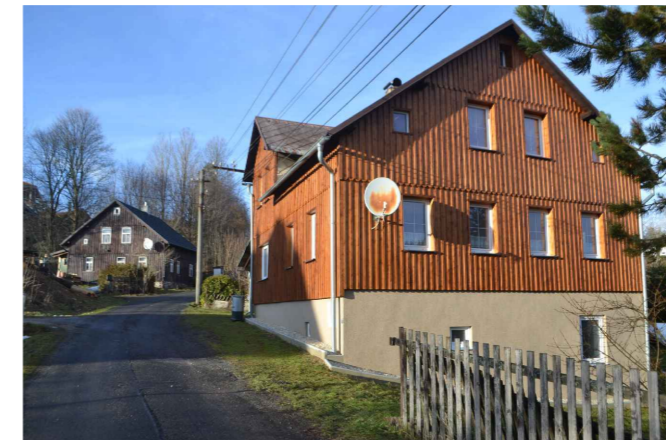
Obr. 4: Dům č. p. 425 v roce 2023, Bublava. Objekt má vyměněné svíslé dřevěné bednění s krycími listy. Rozestupy mezi krycími listy jsou kratší a jejich rozložení je pravidelné. Jak dřevěné obložení, tak pozadí prodláží změnu barevnosti. VÝŠKOVÁ, Dominika (fotograf), 2023. Vlastní archiv autora.
