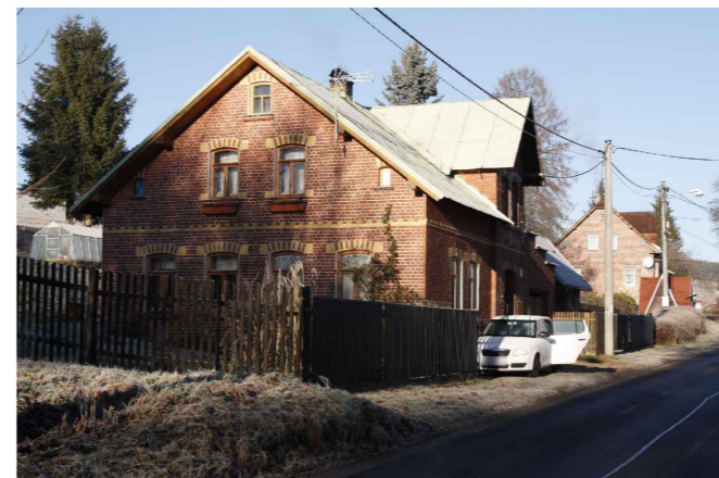
Obr. 1: Dům č. ev. 105 v roce 2023, Bublava. Jedná se o rodinný dům z rezných cíhel patrně z počátku 20. století. Režné zdvo vyvolává charakteristický výraz domu v tomto regionu. Červené režné zdvo bylo použito v kombinaci se žlutými cihlami vyzrazující ostění oken a patrovou římsu. VÝŠKOVÁ, Dominika (fotograf), 2016. Vlastní archiv autora.
