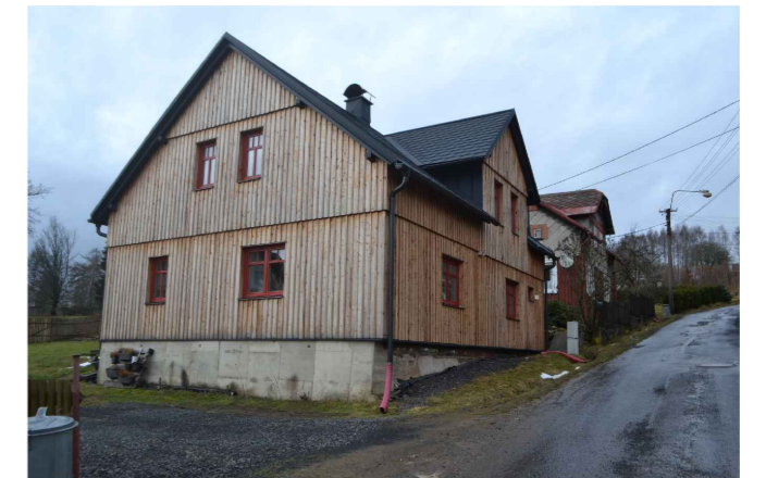
Obr. 6: Dům č. p. 505 v roce 2023, Bublava. Objekt má obnovovanou fasádu stavby. Fasáda je provedena v souladu s místní tradicí svíslým bedněním a krycími listy. Ztratila se však charakteristický ornamentální prvek obložení eternitovými šablonami, jehož existence je však sama o sobě z hlediska zdravotní závažnosti nežadoucí. VÝŠKOVÁ, Dominika (fotograf), 2023. Vlastní archiv autora.
