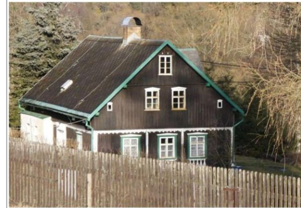
Dům č. ev. 87, pohled z jihozápadu (Bublava – okres Sokolov, foto D. Výšková, 2016)
