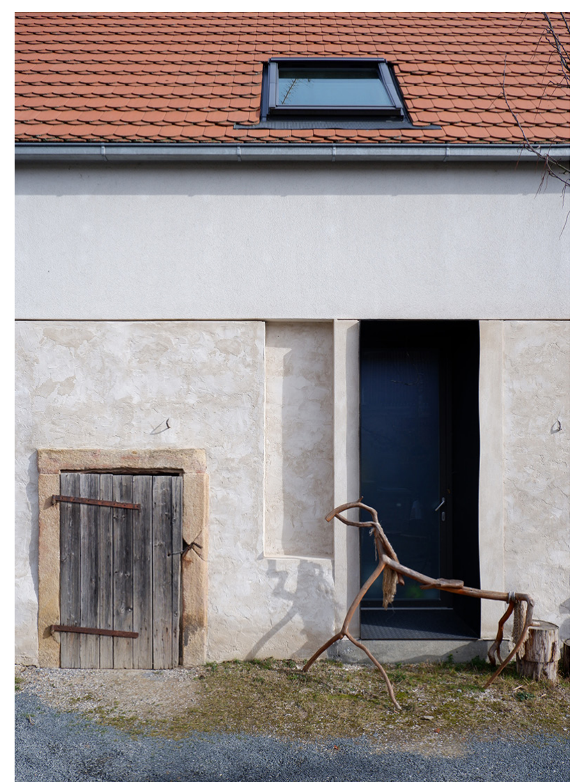
▲ Přestavba hospodářského dvora Bukovec (projectstudio8). Fotografie z oficiální prezentace (vlevo) v porovnání se stavem v roce 2022. Fragment kamenné zdi byl omítnut tradiční technikou. Toto řešení je méně násilné než prezentace obnaženého zdiva, zachovává autenticitu původní stavby, a přesto zůstává kontrast s novou konstrukcí.
